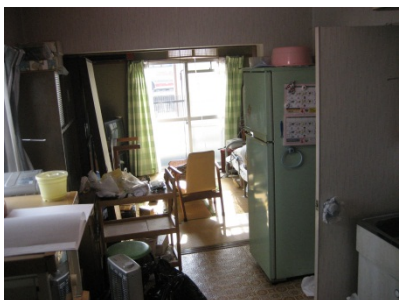
<施工前> (キッチンリニューアル工事)
