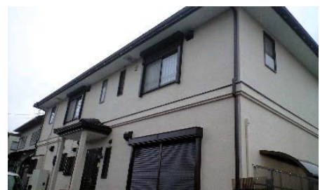
<増改築塗装工事の自社施工例>
